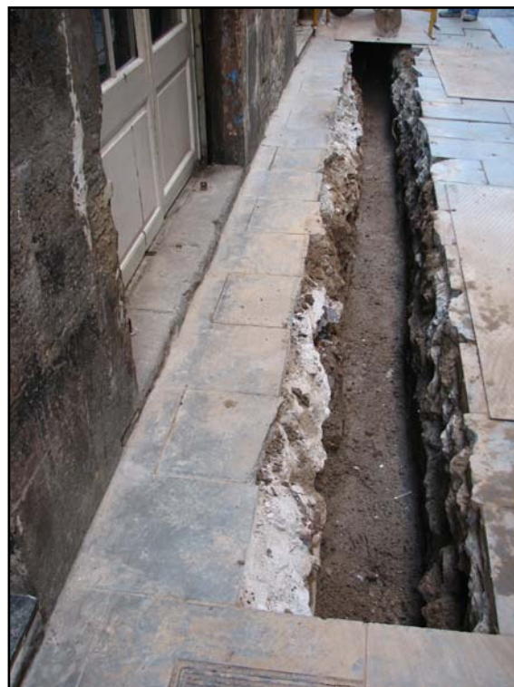
Foto 2: Detall d'un tram de la rasa.
