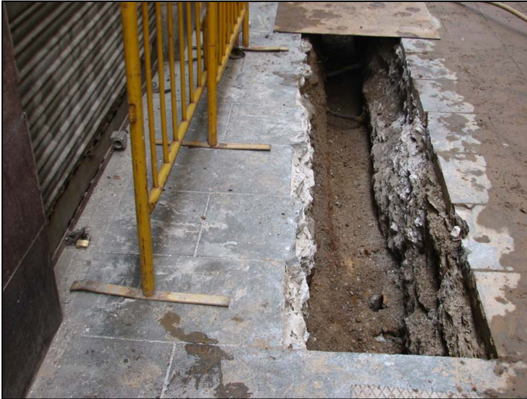
Foto 3: Detall d'un tram de la rasa.
