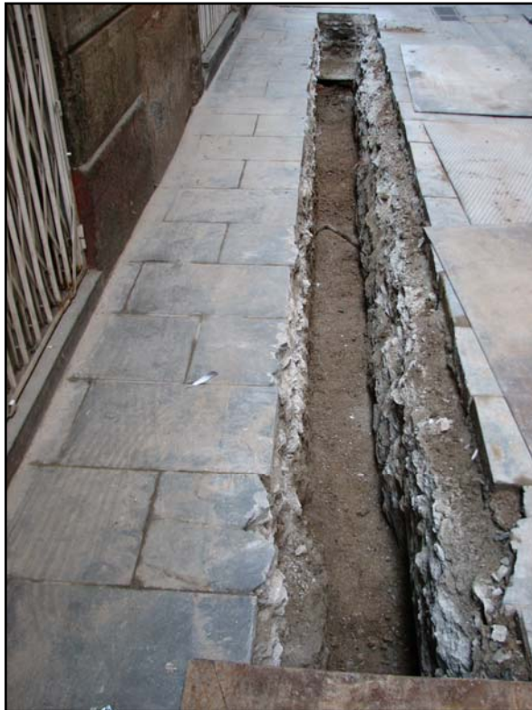
Foto 1: Detall d'un tram de la rasa.
